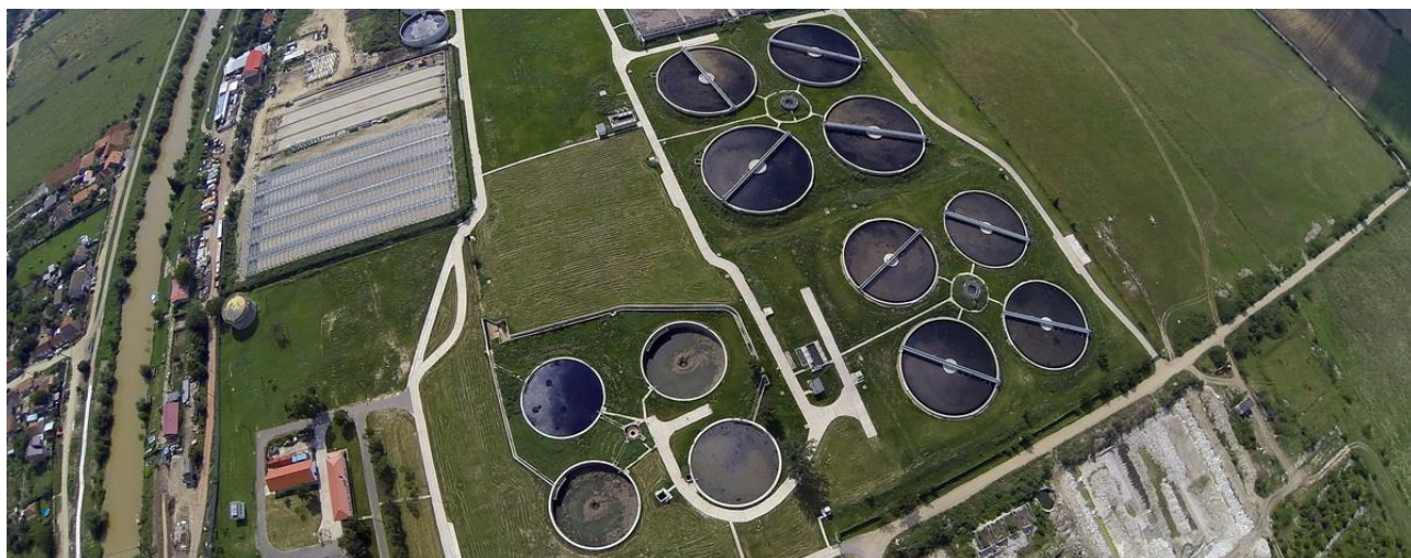
Foto: Stația de Epurare „Stan Vidrișin” din Timișoara
